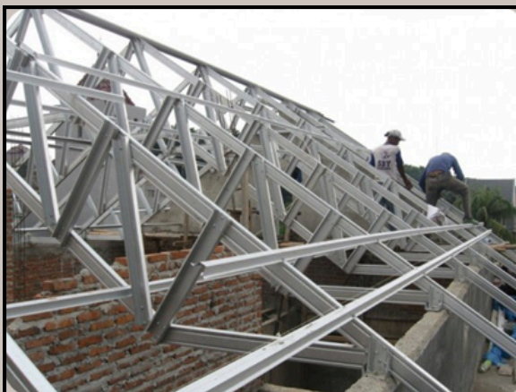
Kerangka bumbung dari keluli terbentuk sejuk
